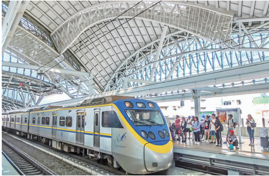
（左圖）新台中車站的月台底層與遮陽雨棚之間，藉由鋼構棚架構築出虛化空間。
